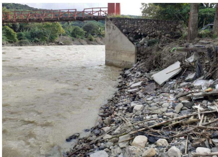
FIGURA N°01: TRAMO CRÍTICO EN EL CAUCE DEL RIO UTCUBAMBA, EN EL PUENTE EL SALAO PRESENTANDO EROSION EN LA MARGEN DERECHA DEL RIO UTCUBAMBA EN EL SECTOR HUINGO, DISTRITO DE CAJARURO, PROVINCIA UTCUBAMBA - AMAZONAS
